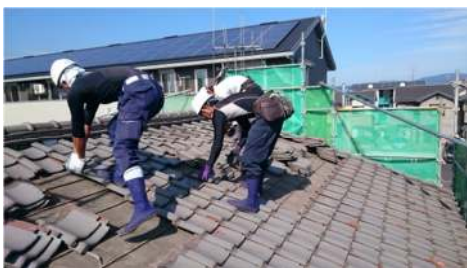
（写真 左：瓦の解体作業 中：瓦チップ「びんごテコラ」 右：エクステリアでの使用例2枚）
